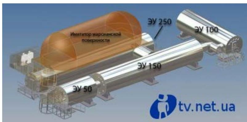
В 2007 году специально для проекта «Марс-500» был построен дополнительный, четвертый, герметичный модуль объемом 250 кубических метров (ЭУ-250). Затем началось строительство пятого модуля с имитацией марсианской поверхности.
