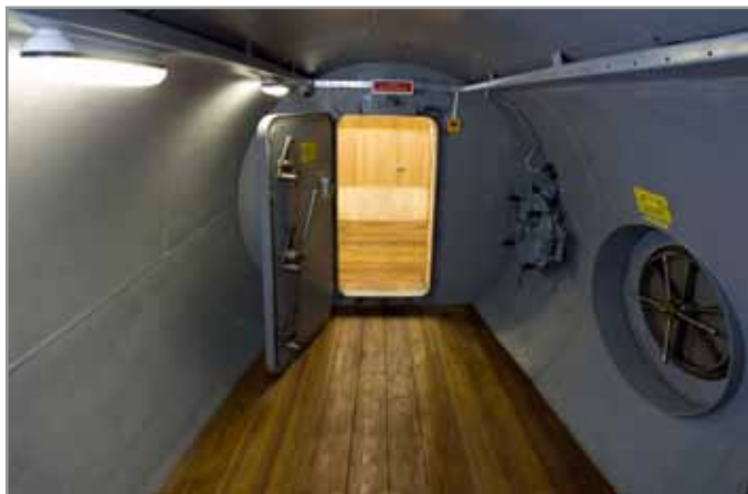
Переход между жилым и складским модулями. Справа расположены шлюзовые камеры
